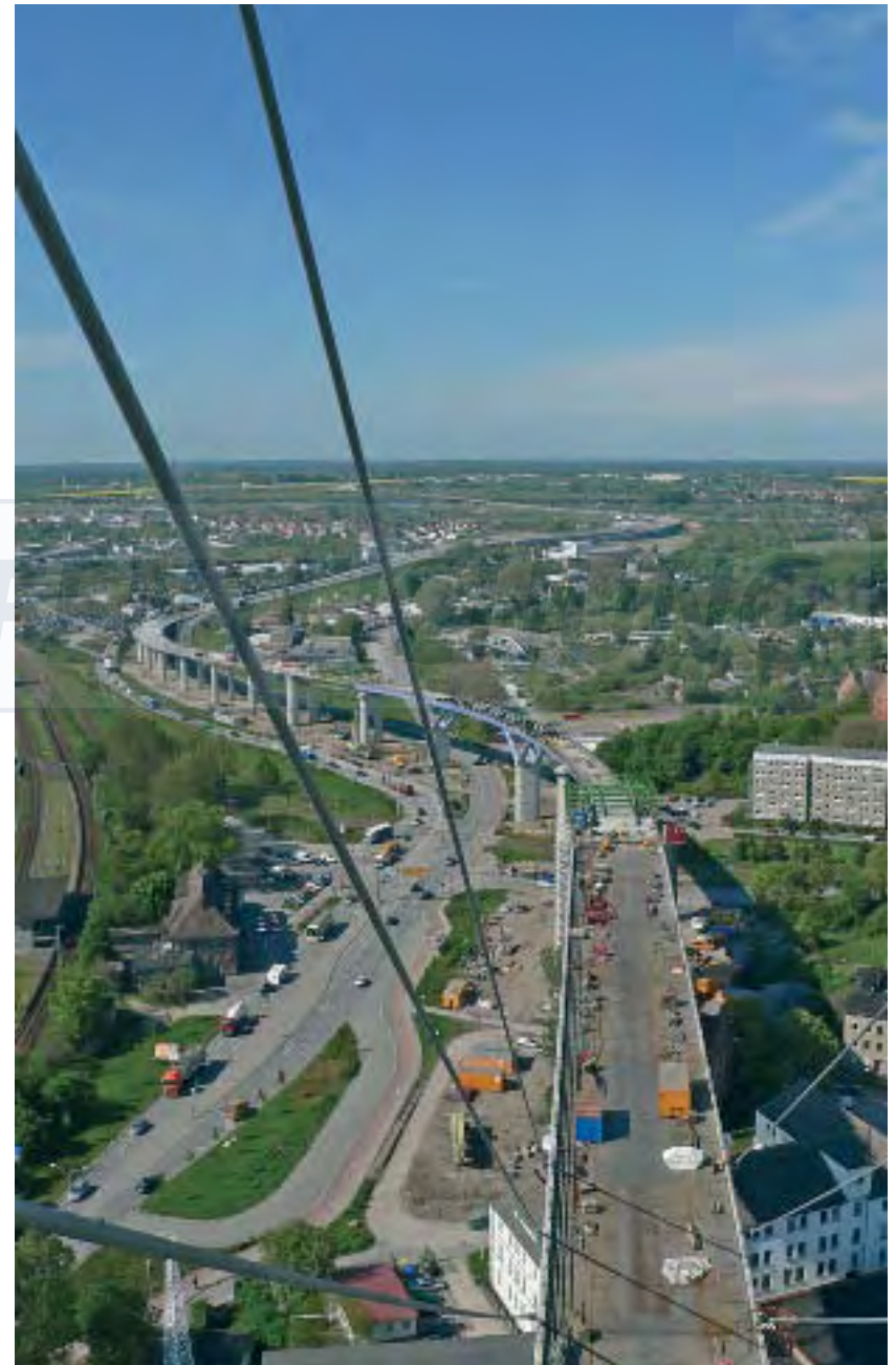
Blick vom Pylon nach Südwesten.
