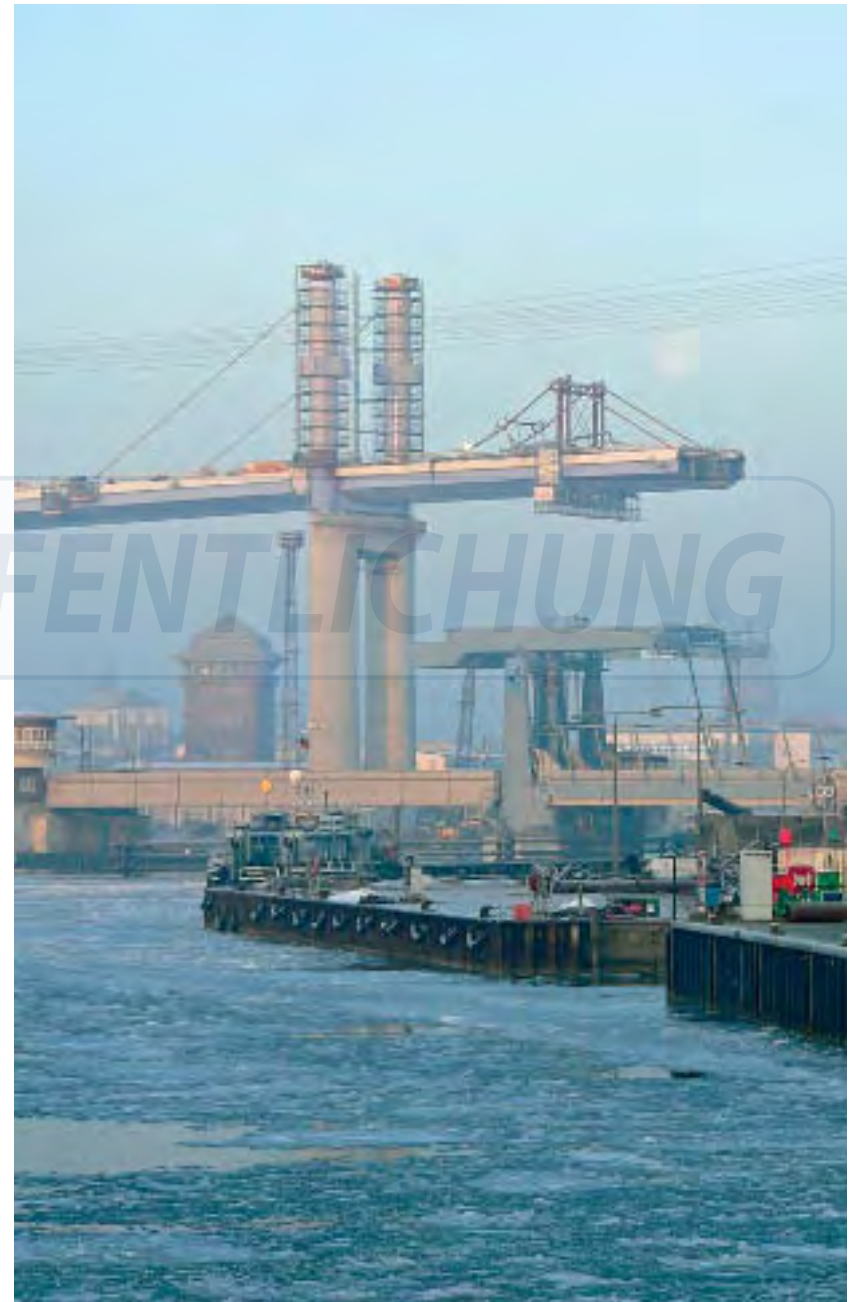
Im Januar 2006 werden die ersten Seile montiert.
