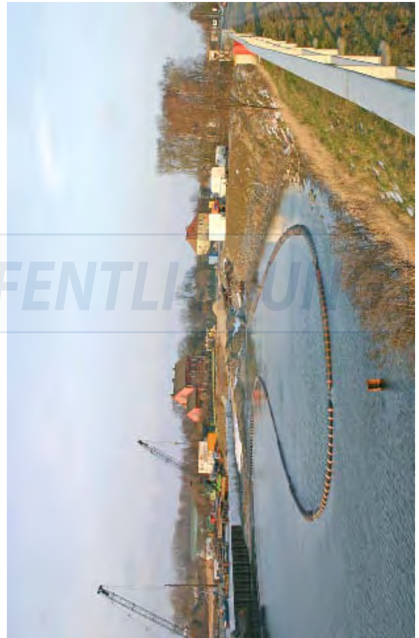
Herbst 2004. Der Spundkasten wird fertig gestellt.
