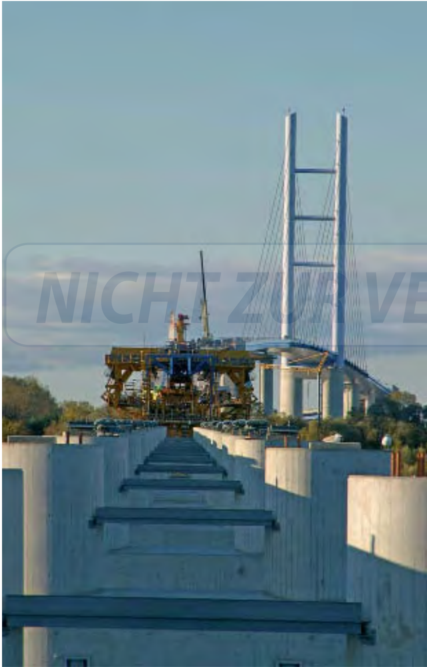
Die Vorschubrüstung kriecht über die Pfeiler des Strelasunds.
