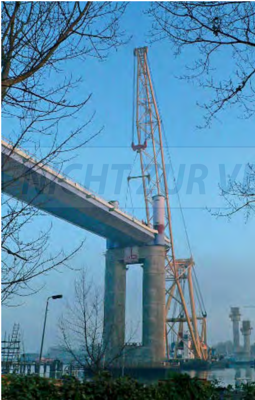
Die Montage des Pylonfußes.
