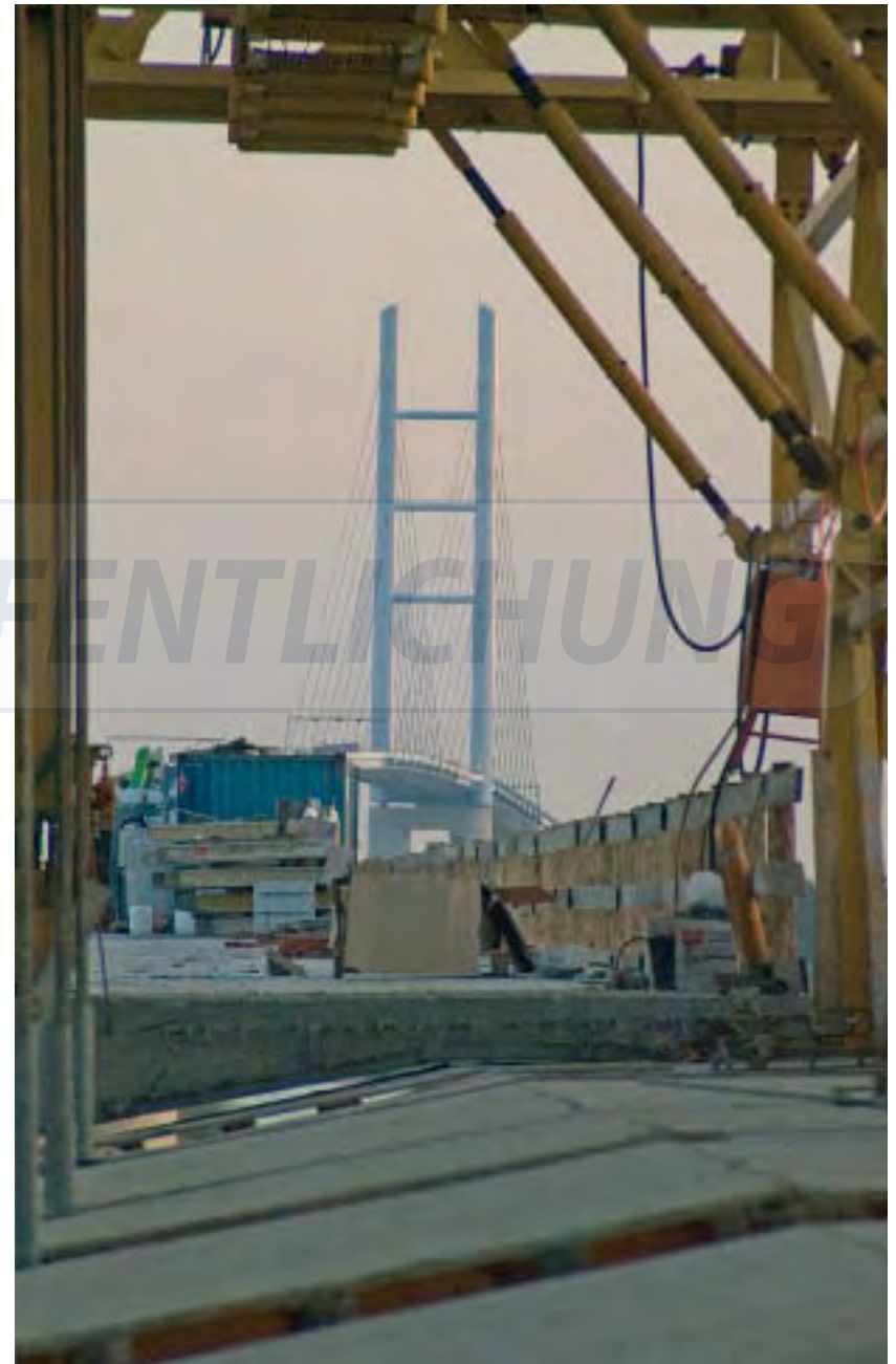
Blick durch die Vorschubrüstung auf den Pylon.
