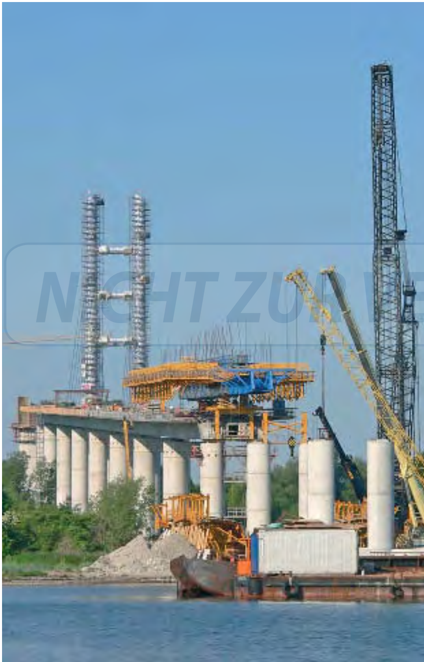
Das Vorschubgerüst wird zum Strelasund umgesetzt.
