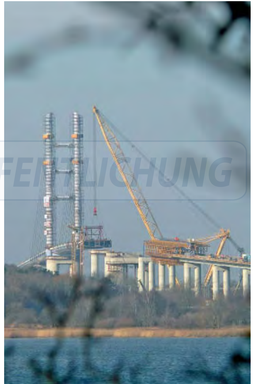
Montage des letzten Freivorbausschusses.
