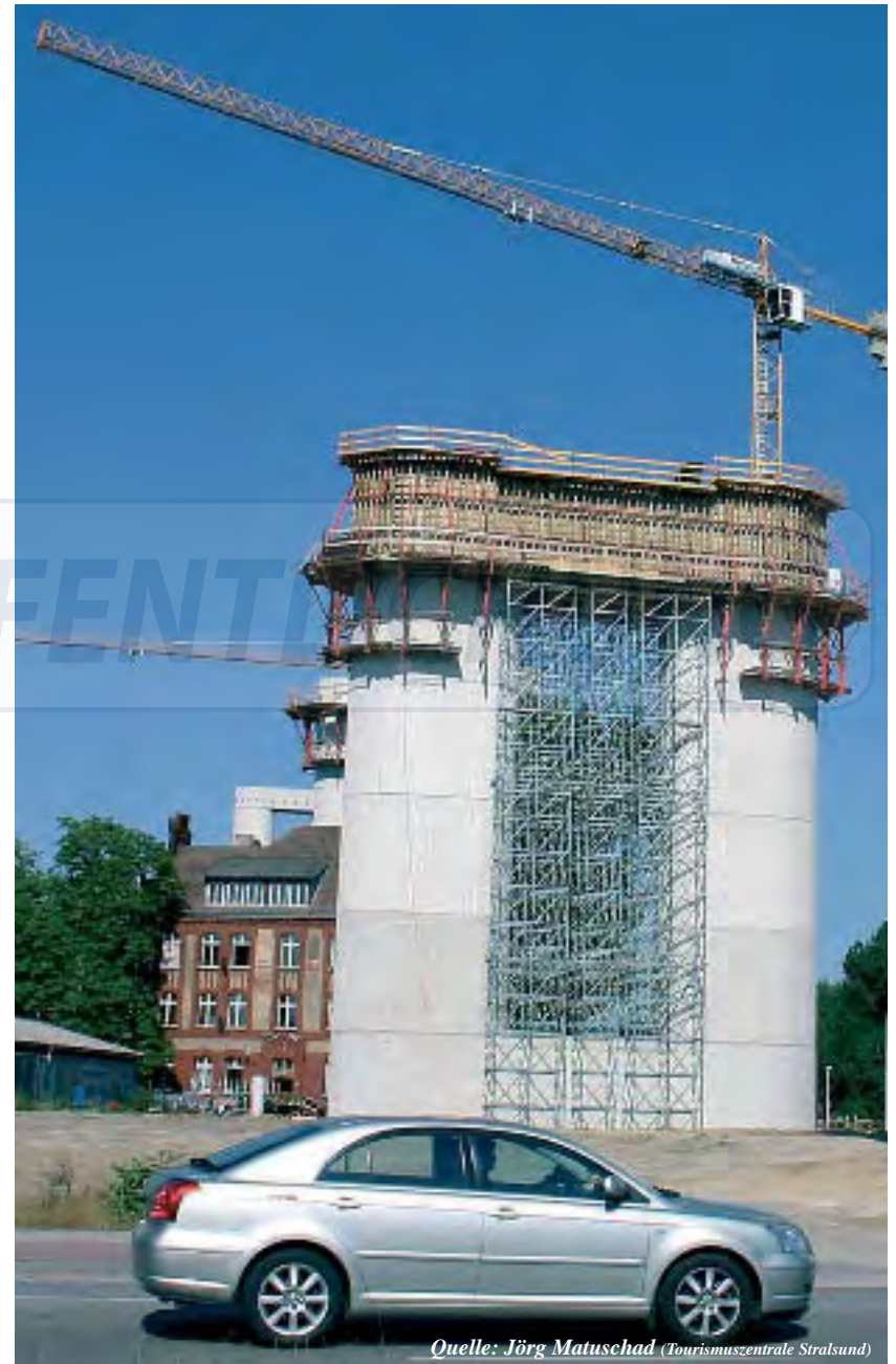
Der Trennpfeiler, Achse 170.
