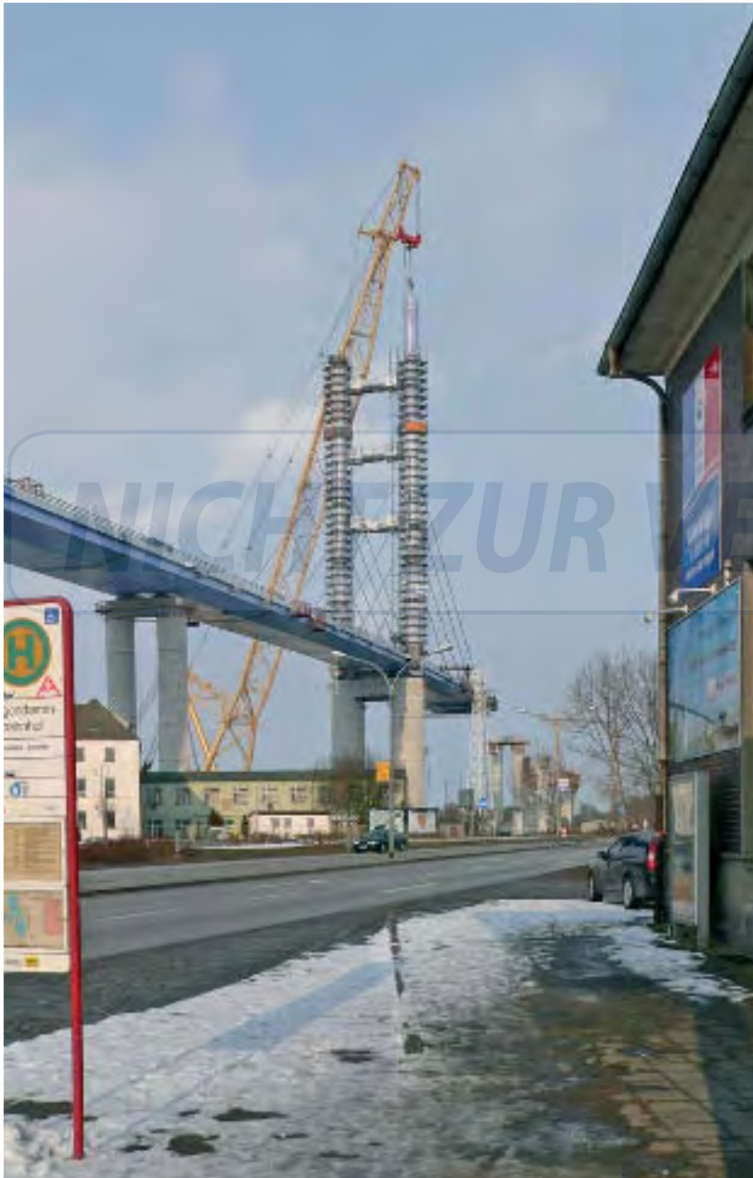
Die Montage der Pylonspitze.
