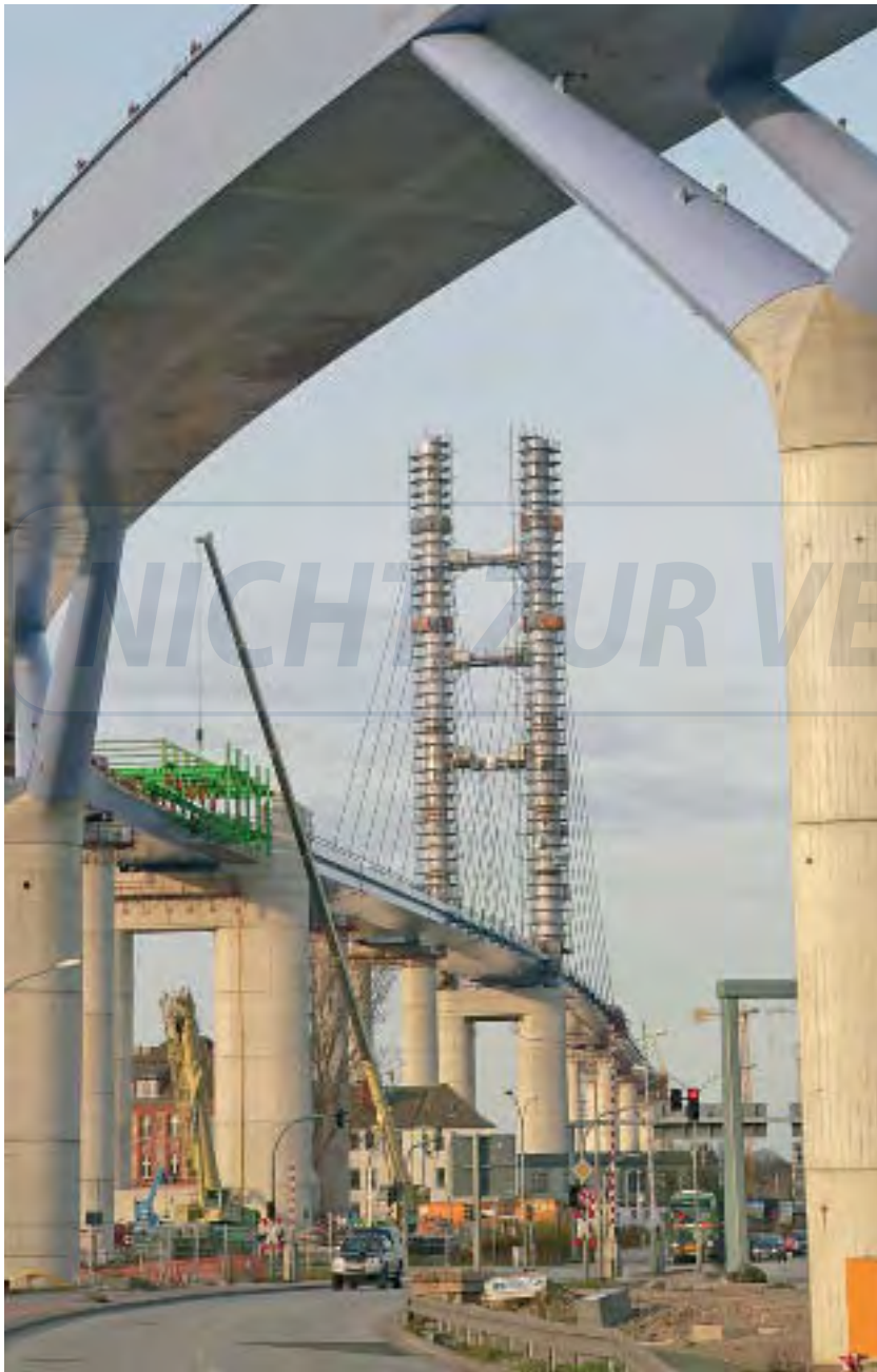
Montage des Schalungswagens auf dem Verbundabschnitt.
