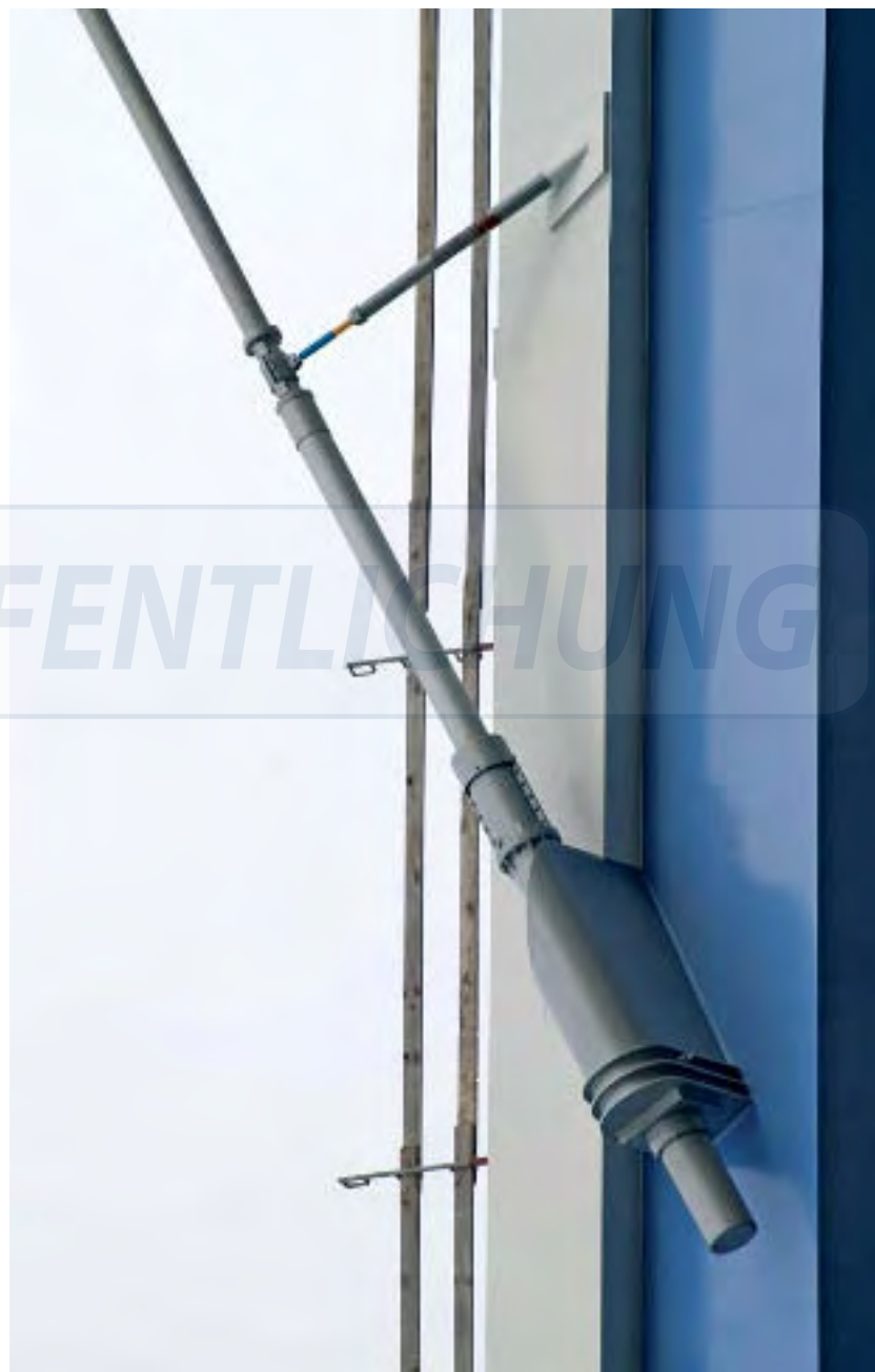
Einige Litzenbündel benötigen Schwingungsdämpfer.
