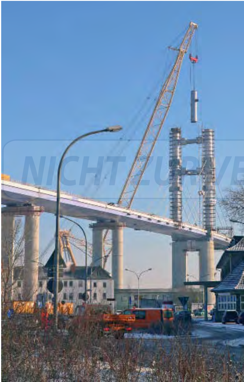
Der Kranausleger hat eine Länge von 175 m.
