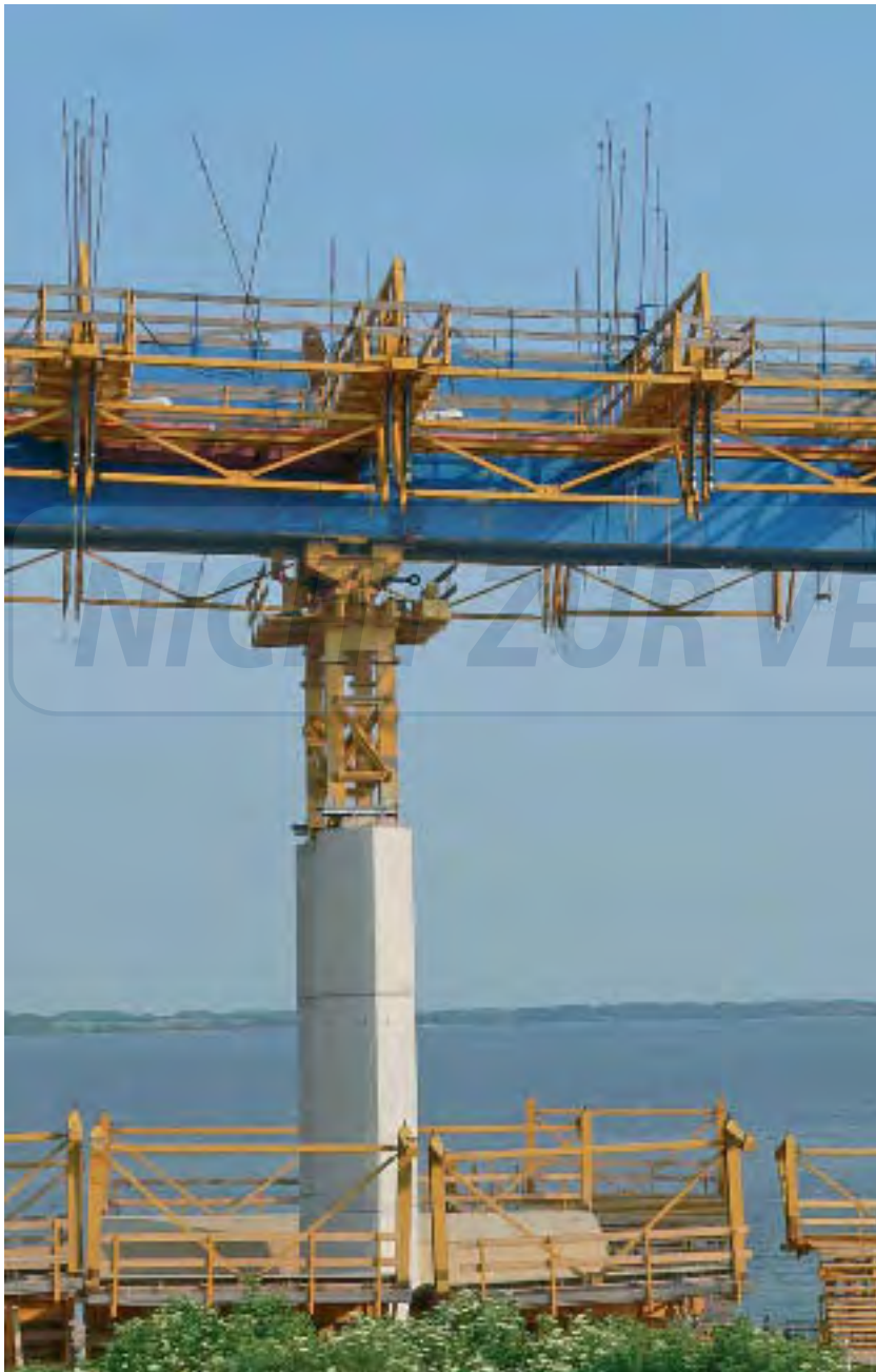
Die vordere Lagerung des Vorschubgerüsts.
