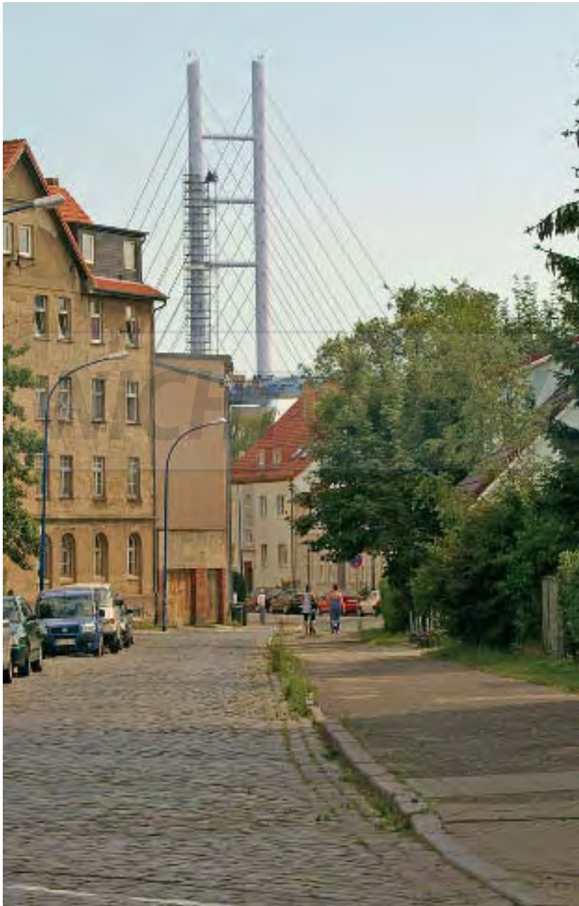
Der Pylon ist fertig und wird ausgerüstet.
