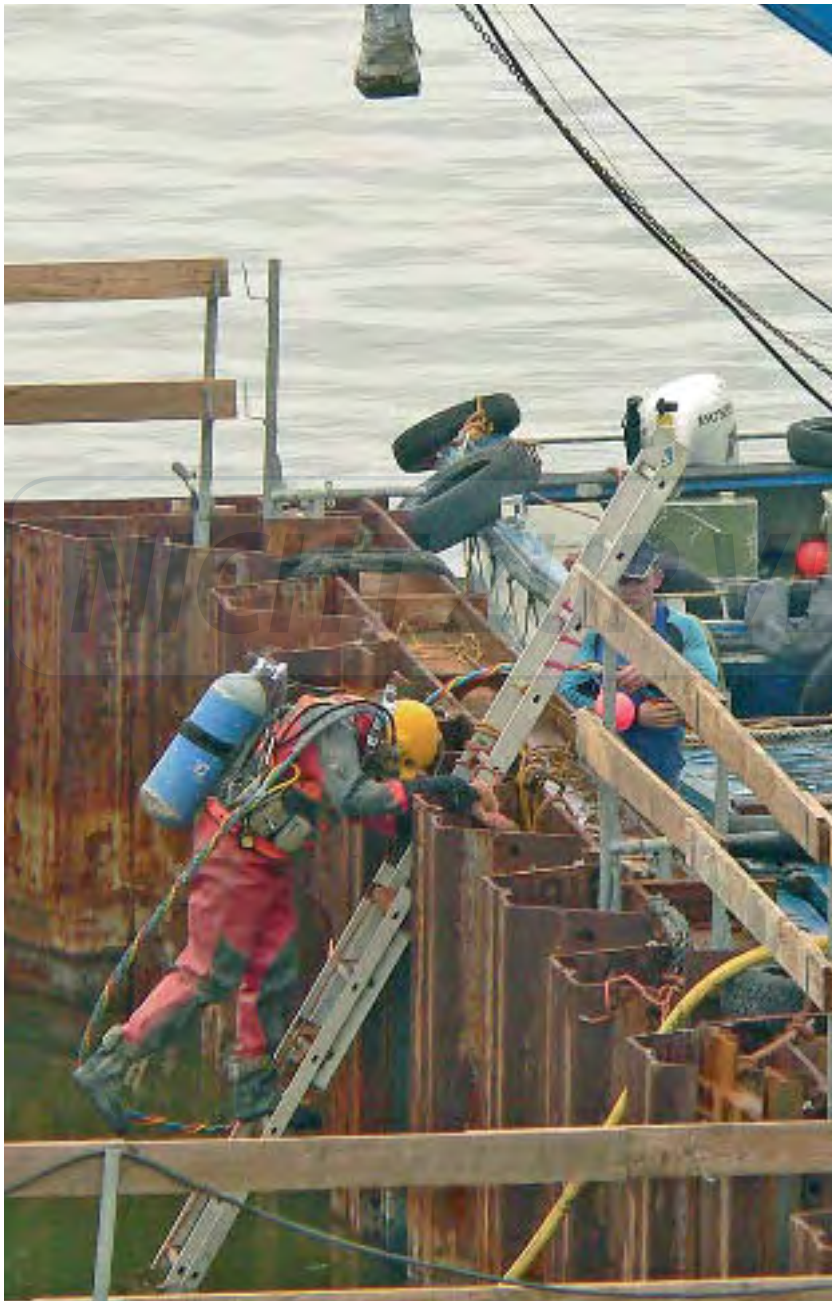
Der Bautaucher steigt in den Spundkasten.
